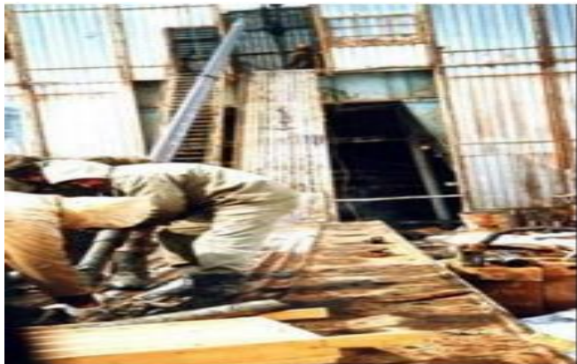
Рис. 1.1. Процесс извлечения колонки ориентированного керна
