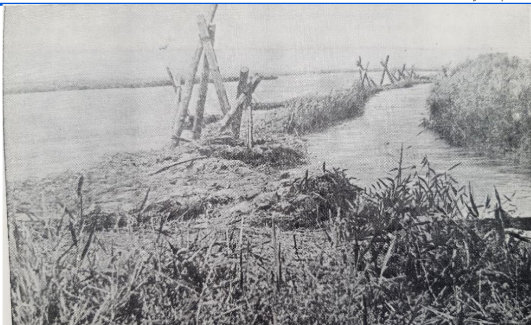
1-rasm. «Sepoya» tipidagi oqim qaytaruvchi to'siqlar yordamida daryodagi suv kanalgaga yo'naltiriladi.
