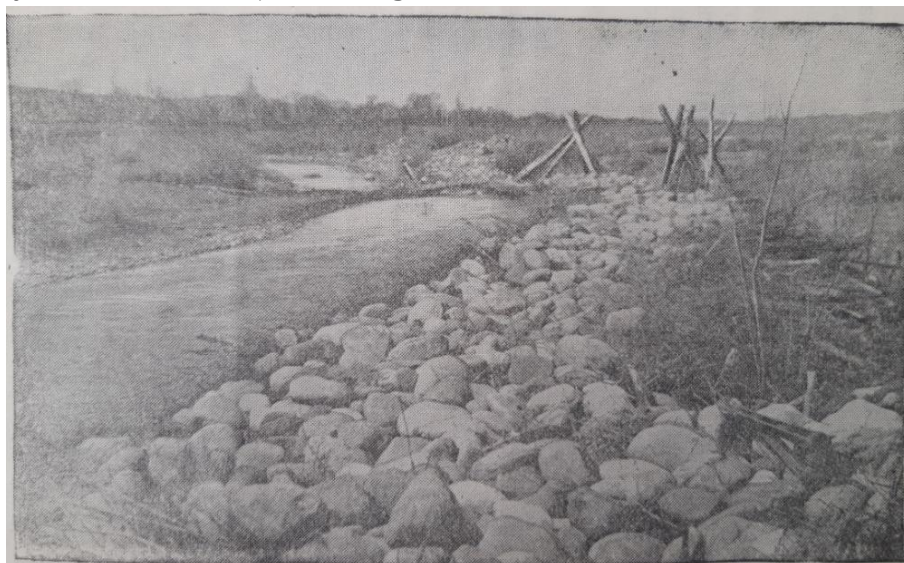
4-rasm. Kanal sohillarini yuvilishdan himoya qilish uchun tosh va butalardan qurilgan (toshto'g'on) dambalar sepoyalar bilan mustahkamlangan.
