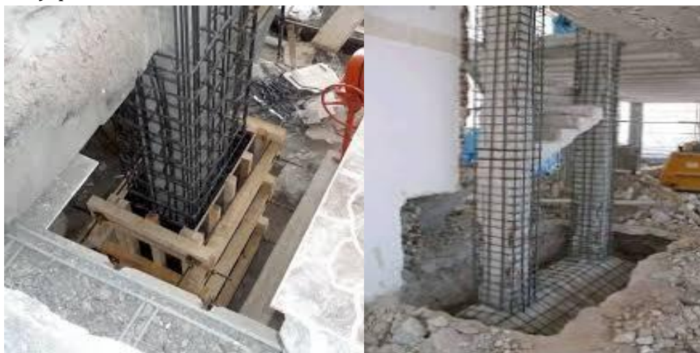
2-rasm. Ustun konstruksiyalarini qo'shimcha armatura bilan kuchaytirish
