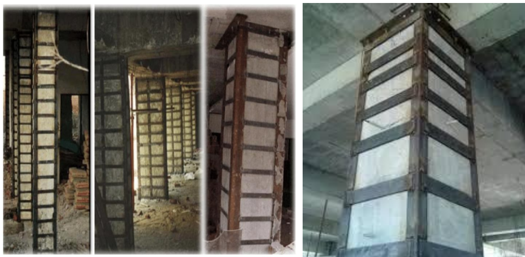
3-rasm. Ustun konstruksiyalarini metal qoplamalar bilan kuchaytirish
