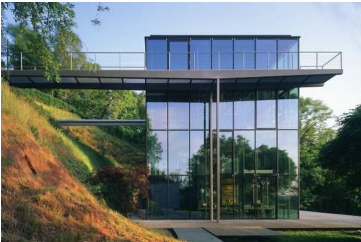
Рис. 1. Дом R-128, Штутгарт, Германия (архитектор Вернер Зобек, компания «Werner Sobek Ingenieure»)
